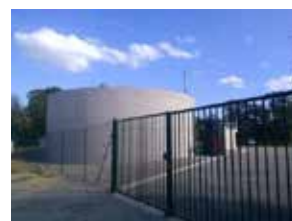
Station d'épuration de Lignièrès
