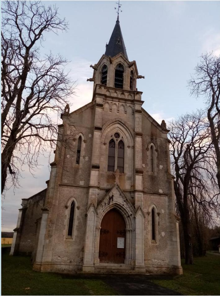
Des fissures inquiétantes et un affaissement du sol, nous ont contraint à interdire l'accès au public pour des raisons de sécurité par arrêté municipal N° 11-2021 en date du 2 mars 2021 et jusqu'au 1 er mai 2021.
